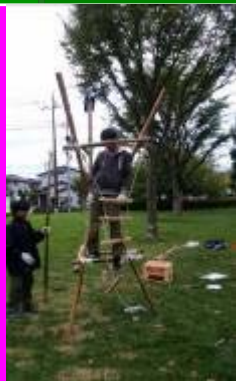
完成した三脚信号塔 しかし、安定感がなく、 上部に上れず
