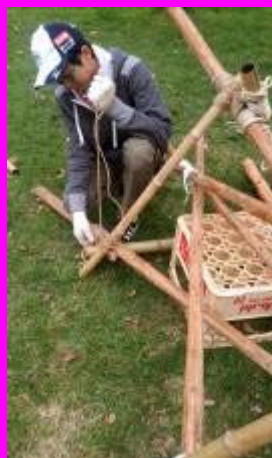
合体作業、角縛 り
