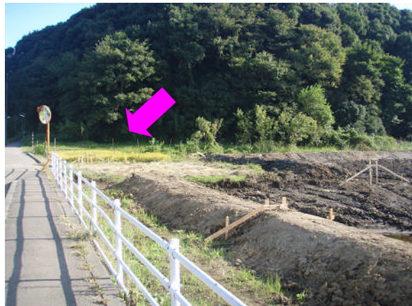
田んぼ周辺は、工事中。
